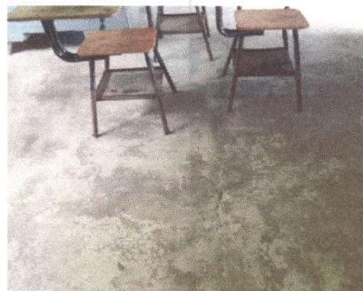
Foto 4: Sustitución de piso ceramico (tres aulas)
