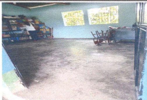
Foto7: Sustitución de piso cerámico.
