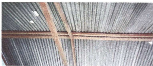
Foto 3: Estructura de techo (tendales y reglas)
