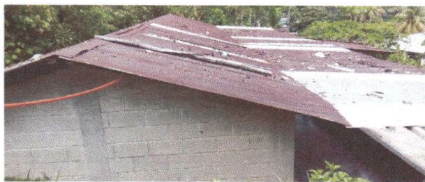
Foto1: Cubierta de lámina (techo de tres aulas).
