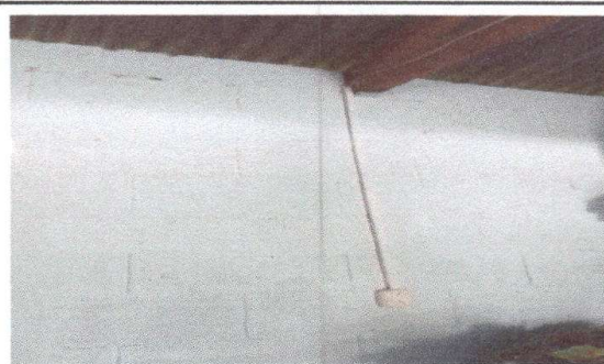
Foto 8: Reparación del sistema eléctrico.
