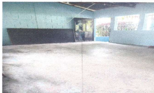
Foto 6: Sustitución de piso cerámico.
