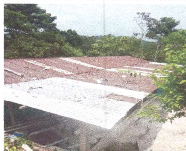
Foto 2: Cubierta de lámina (Corredor)
